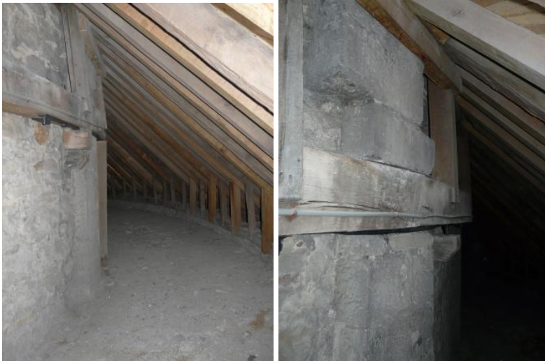
I.5.3.28A links: zuidelijke transeptarm, apsis, lessenaarsdak van de galerij met achterwand van het triforium (links) (foto: JW). Zie § I.5.6.10.
