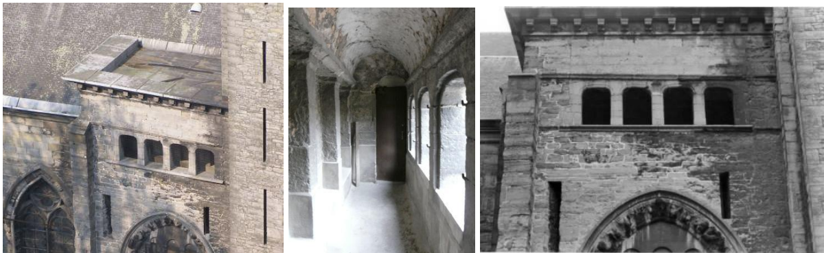
I.4.3.3A. Links: de bovenzijde van de zuidgevel van de uitbouw van de zuidelijke entreehal (foto: JW).
