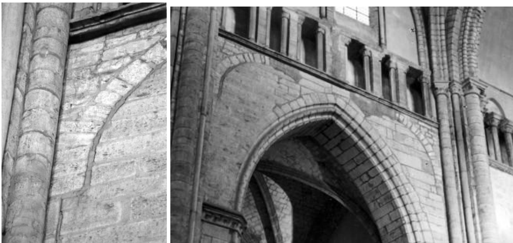
I.5.3.35A links: zuidelijke transeptarm, dubbeltravee, oostzijde, aanzet van boogprofiel in het metselwerk naast de vieringpijler (foto: JW).
