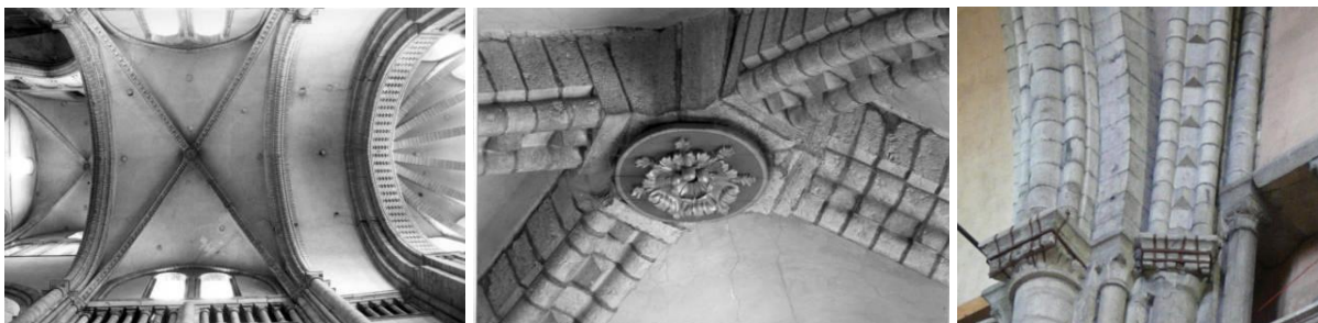
I.5.2.32A links: noordelijke transeptarm, gewelven en gedeelte van de opstand ter plaatse van het schip (foto: JW).
