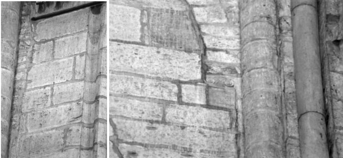
I.5.3.36A links: zuidelijke transeptarm, dubbeltravee, oostzijde, bouwnaad naast de vieringpijler onder het kapiteelfries van de 13 de -eeuwse pijler (foto: JW).
