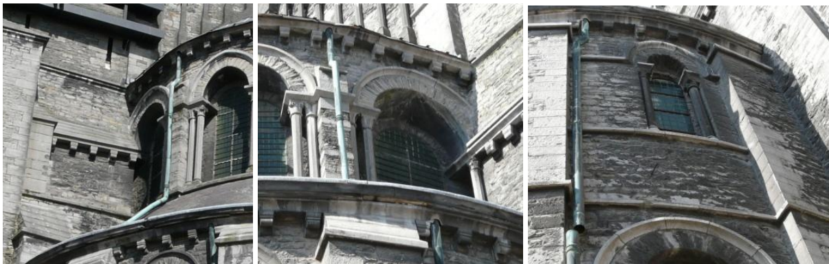
I.5.6.10.2A links: zuidelijke transeptarm, aansluiting van de lichtbeuk van de apsis tegen de Parochietoren (foto: JW).
