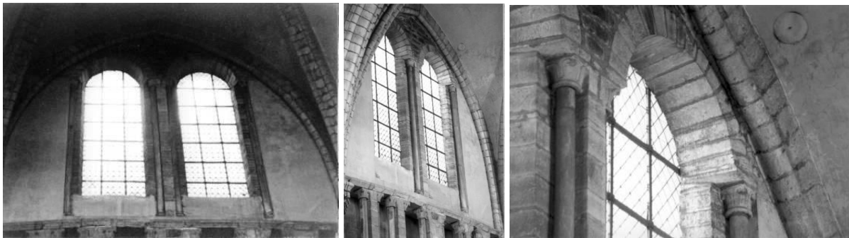
I.5.2.31A links: noordelijke transeptarm, oostzijde, dubbeltravee, lichtbeuk (foto: JW).
