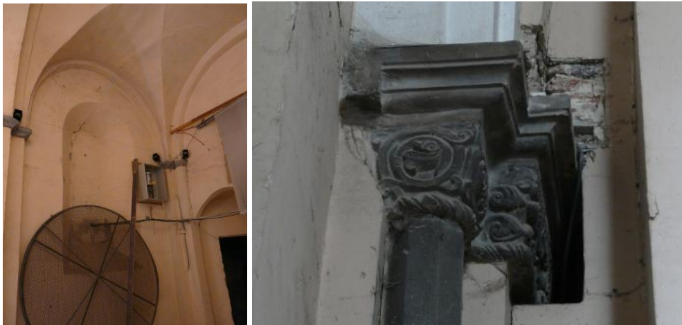
I.5.6.3A links: noordelijke zijbeuk van het transept, westwand met dichtgezet venster. Rechtsonder de toegang tot het trappenhuis in de Brunintoren (foto: JW).
