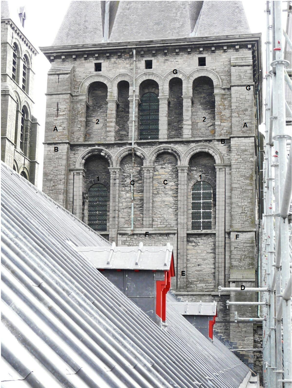
I.5.4.1A: Vieringtoren, westzijde, gezien vanaf de zuidzijde van het schip. (1) Niveau 1, (2) Niveau 2, (A) steunberen, (B) waterlijst, (C) blinde delen van de arcade, (D) verzwaaarde steunbeer, (E) verlengde rechtstanden van de buitenste bogen, (F) waterlijst, (G) steunberen (foto: JW).
