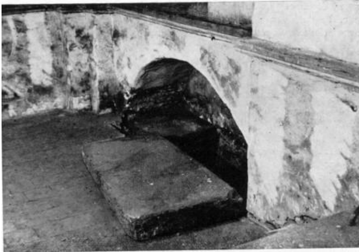
I.4.4.2A. Links: ontlastingsboog in de oostwand van de Catharinakapel met graf van Letbertus Blondus (foto: KIK-IRPA).
