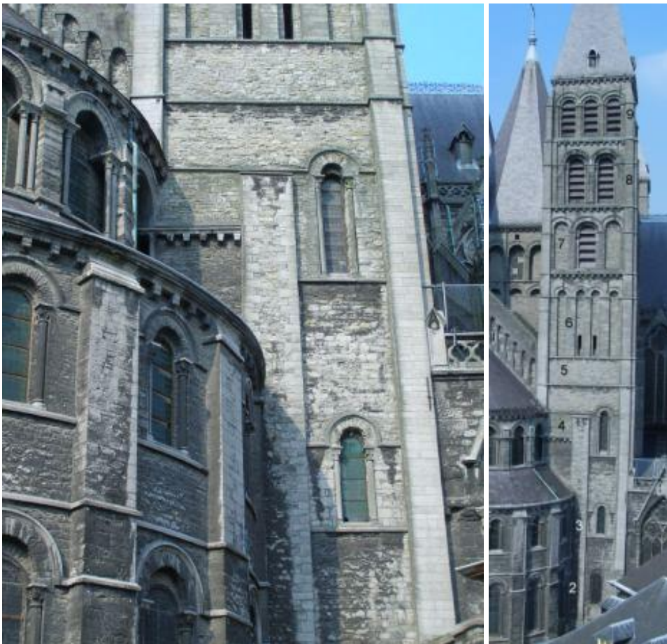
I.5.3.51A links: zuidelijke transeptarm, Mariatoren, niveau 3 en 4 (foto: JW).
