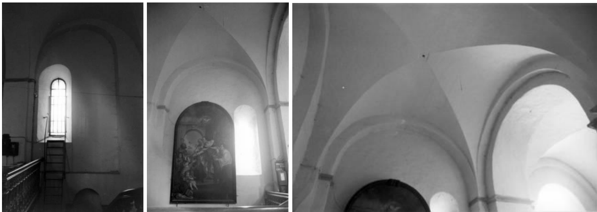
I.2.18A links: westpartij, noordelijk trappenhuis op galerijniveau, westwand met draaivenster (met trap) in de westfaçade (foto: JW).
