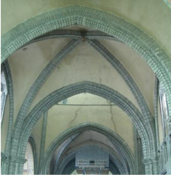
I.5.3.39A links: zuidelijke transeptarm, gewelf van de dubbeltravee gezien vanaf de galerij van de zuidelijke apsis (foto: JW).
