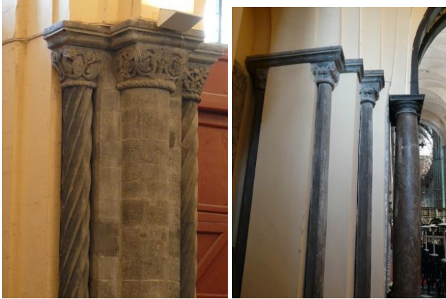
I.2.22A links: westpartij, vestibule, halfzuil en colonnet tegen de verdeelpijler van het westportaal (foto: JW).
