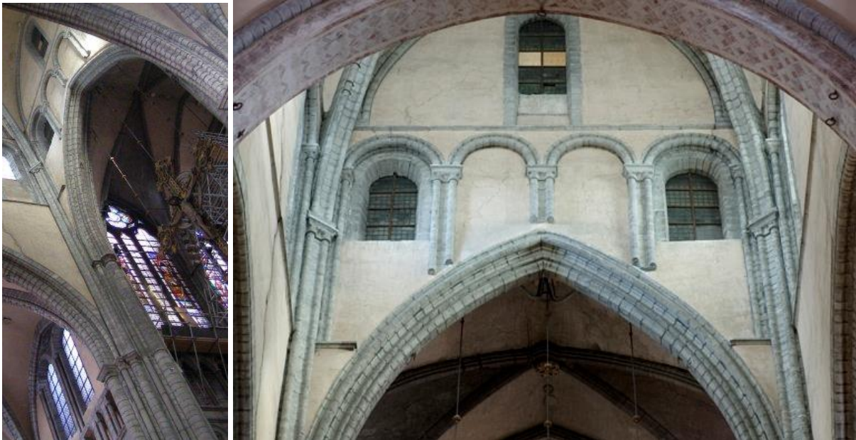
I.5.5.2A. Links: noordoostelijke vieringpijler met de kapiteelzondes van de 12 de -eeuwse oostpartij en het 13 de -eeuwse koor (foto: JW).
