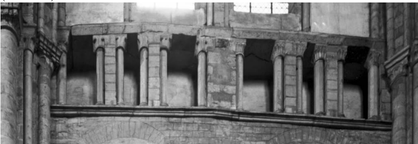
I.5.2.30A links: noordelijke transeptarm, oostzijde dubbeltravee, triforium (foto: KIK-IRPA).
