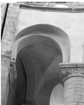
I.5.6.10.1A links: zuidelijke transeptarm, apsisomgang, scheiboogarcade tegen de Mariatoren
