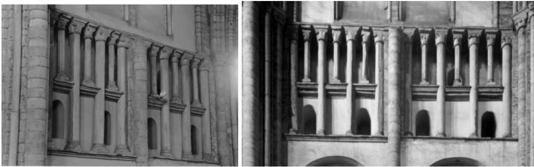
I.5.3.8A links: zuidelijke transeptarm, westzijde, nissenzone en triforium vanuit de apsis gezien (foto: JW). I.5.3.8B rechts: zuidelijke transeptarm, westzijde, nissenzone en triforium, frontaal zicht (foto: KIK-IRPA).
