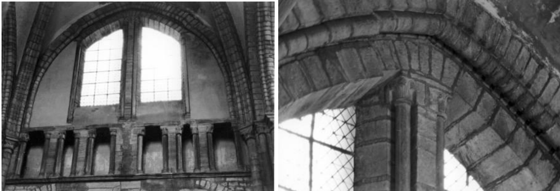
I.5.3.38A links: zuidelijke transeptarm, dubbeltravee, oostzijde, triforium en lichtbeuk (foto: JW).
