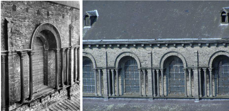
I.3.4A links: schip, loopgang voor de lichtbeuk, circa 1945, met tijdelijk galerijdak (foto KIK-IRPA, Brussel).
