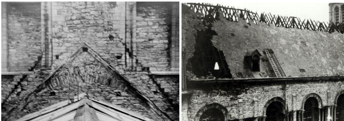
I.3.30A links: de westwand van de vieringtoren in 1941 (foto: KIK-IRPA, Brussel).
