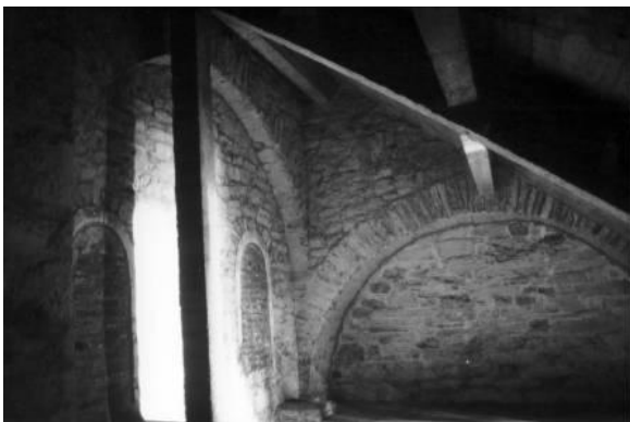
I.5.3.9A links: zuidelijke transeptarm, westzijde, zolder van de galerij. Links de achterzijde van de rondboognissen van de nissenzone, rechts een spaarveld in de noordwand van de Parochietoren (foto: JW).
