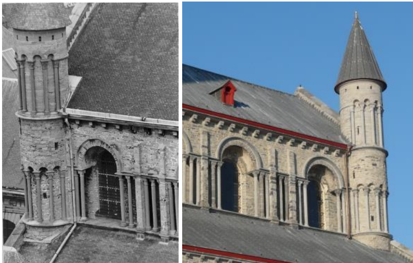
I.3.5A links: zuidzijde van de westpartij met aansluiting op het schip (foto: JW).
