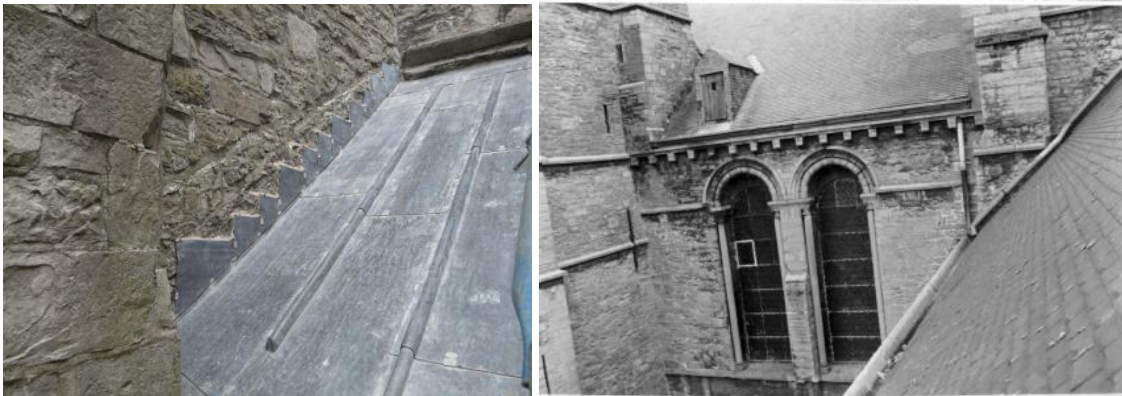
I.5.2.9A links: noordelijke transeptarm, westzijde, dakmoet tegen de Brunintoren boven het dak van de westgalerij (foto: JW).
