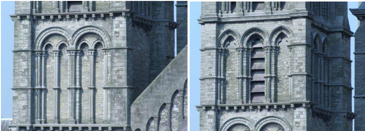
I.5.3.45A links: Parochietoren, zuidzijde, eerste vrijstaande niveau (foto: JW).
