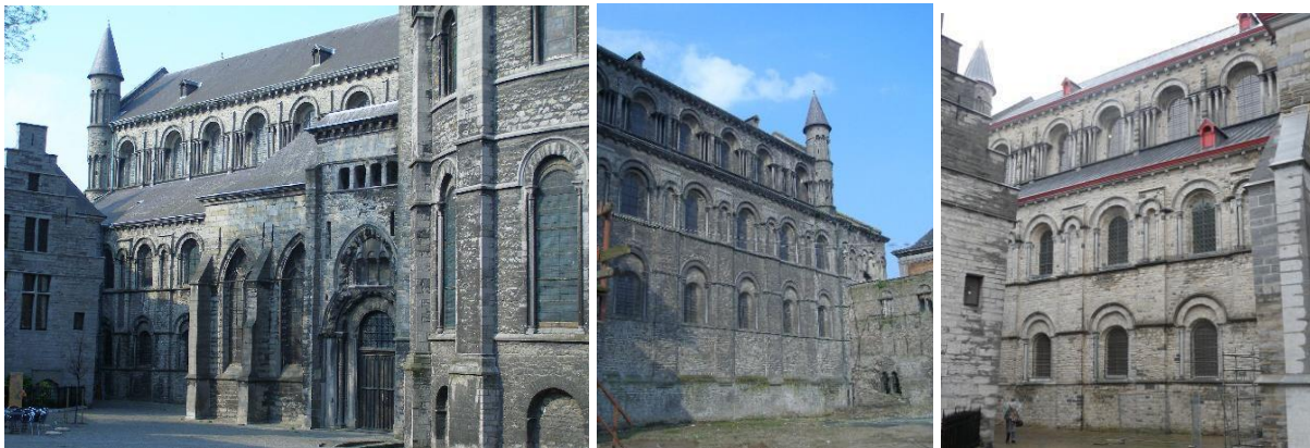
I.3.3A links: zuidzijde van de kathedraal met op de voorgrond de apsis van de zuidelijke transeptarm, vervolgens het zuidportaal, de Lodewijkskapel en het schip (foto: JW).
