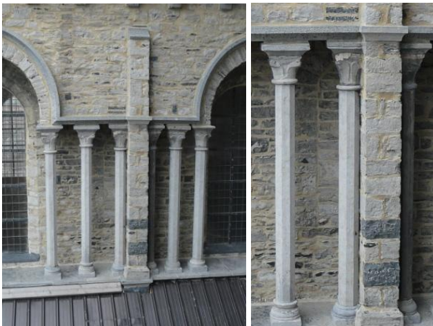
I.3.5A links: schip, zuidzijde, lichtbeuk nabij het transept (foto: JW).
