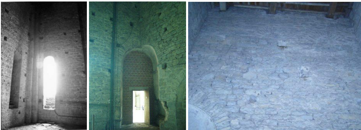
I.5.3.56A links: zuidelijke transeptarm, Mariatoren, zaal op de verdieping, venster aan de zuidzijde en dichtgezet venster aan de oostzijde (foto: JW).
