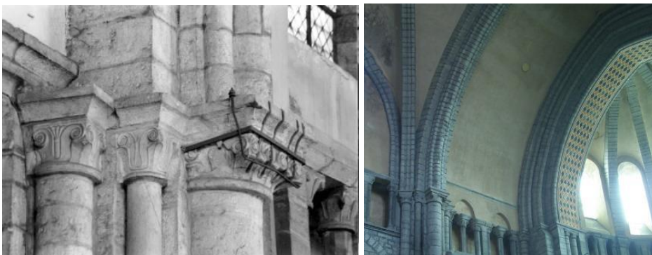
I.5.2.24A links: noordelijke transeptarm, oostzijde, zijde van de dubbeltravee, aanzet tongewelf (foto: JW). I.5.2.24B rechts: zuidelijke transeptarm, oostzijde, aanzet van de gewelven van de middenbeuk (foto: JW).
