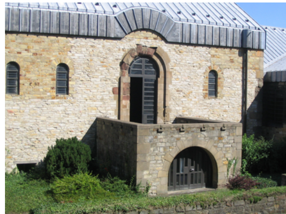
12.21: De uitbouw met balkon van de aula van Paderborn. In het bewaard gebleven opgaande metselwerk is geen spoor gevonden van een opgaande risaliet.
