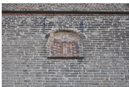
12.10: Het noordelijke arcadevenster in de kerktoeren van Warnsveld. Het verdwenen deelzuiltje is te herkennen in de bakstenen opvulling van het venster.
