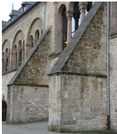
12.20: De uitbouw van de aula van Goslar is in de basis authentiek (zie metselwerk vlak boven het maaiveld) maar er is geen zekerheid over de opbouw: balkon of risaliet.
