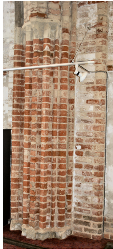
11.16: Bakstenen bundelpijler tegen de westgevel van de kerk (fase 1). Vanaf het kapiteel verandert de architectuur (fase 2).
