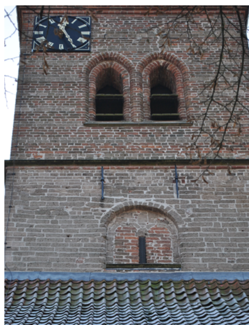
9.16: Eén van de romaanse vensters in de toren van de Sint-Martinuskerk van Warnsveld. Op de plaats van het verdwenen deelzuiltje is nu een smalle lichtopening.
