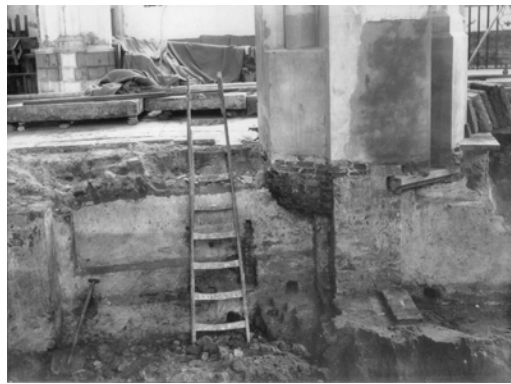
8.63: Sporen van een van de noordelijke muurnissen van de crypte tijdens de opgraving van 1911.
