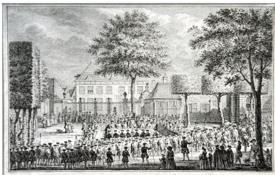
7.32: Het laatste leengericht van het Kwartier (graafschap) van Zutphen op het plein 's-Gravenhof in 1764. De ceremonie vond plaats op het middendeel van het plein.
