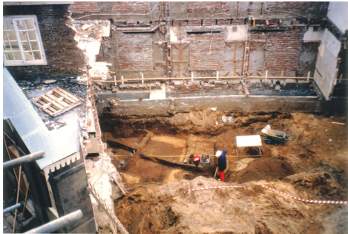
5.7: Opgravingen onder het koetshuis van Huize van de kastele (werkput 3).
