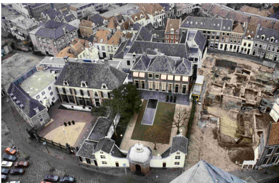
5.2: De adellijke winterhuizen Huize van de Kastele (links), Hof van Heeckeren (midden) en Oude Hof van Bronckhorst (in de opgraving, rechts) ten westen van het plein. Hier vonden tussen 1993 en 1999 diverse grote en kleinere opgravingen plaats.
