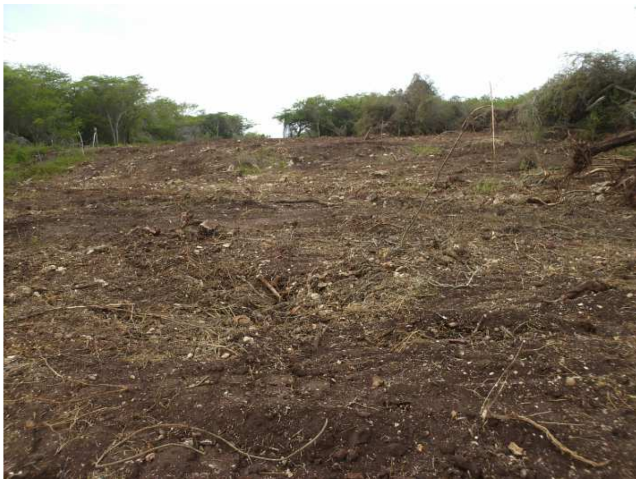
Figura 25. Área del sitio Loma Perenal en el 2008 después del desbroce de la vegetación con maquinaria.
