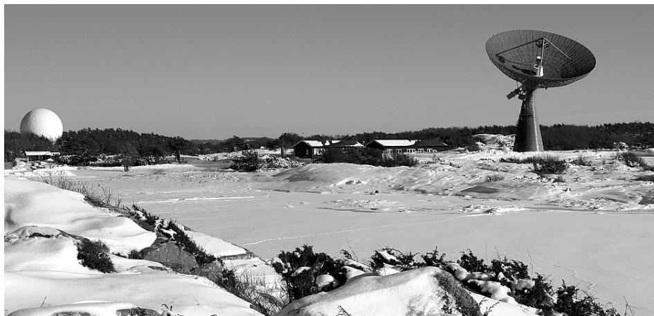
Figuur 2: De Onsala Space Observatory (Zweden) in de winter. Aan de rechterkant staat de 25 m telescoop en links de radome met de 20 m antenne. Beide telescopen worden gebruikt voor VLBI waarnemingen en zijn deel van het Europese VLBI Netwerk. Credit: Onsala Space Observatory/Magnus Thomasson
