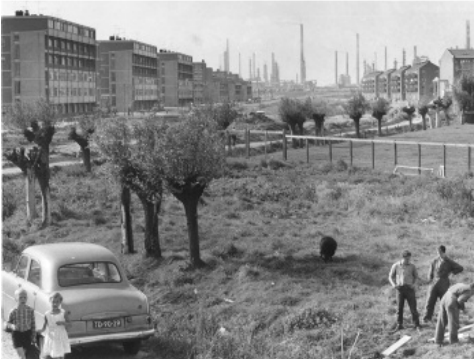
Woningbouw en industrie, 1959
