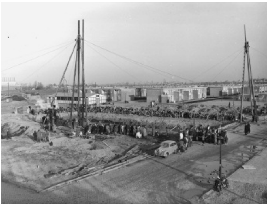
Eerste paal geslagen voor sociale woningbouw in Sloterveer, 1954
