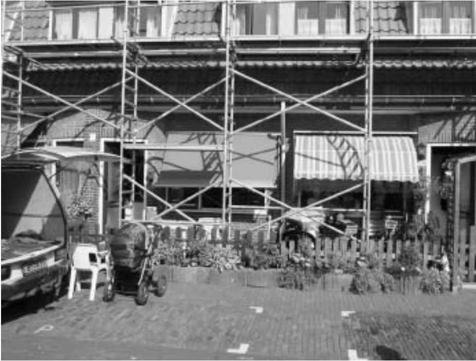
Renovatie van woningen in Den Haag-Rustenburg
