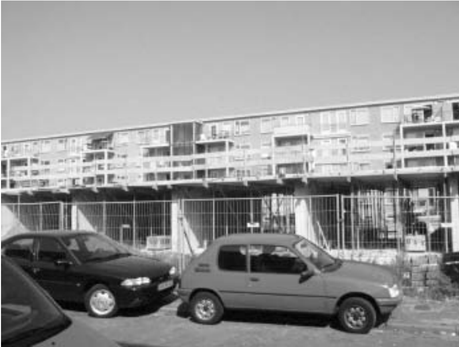
Herstructurering in Den Haag Zuid-West
