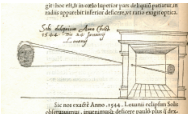
De vroegst bekende afbeelding van een camera obscura, door Gemma Frisius in zijn boek De radio astronomico et geometrico liber uit 1544. [THYSIA 1520: 2].
