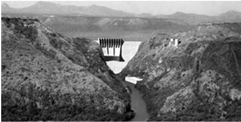
Figuur 2 Ethiopië zet in op de bouw van megadammen: beeld van de Gibe-3-dam, in aanbouw in Zuidwest-Ethiopië.
