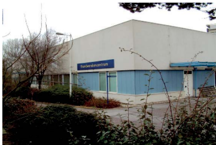
Figure 2: Burn Centre Zuiderziekenhuis Rotterdam 1986
