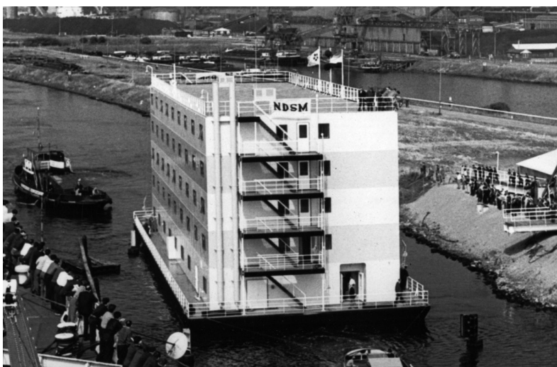
Hoogovens huisvestte in 1968 een deel van haar arbeiders in een drijvend woonoord op het Noordzeekanaal.
