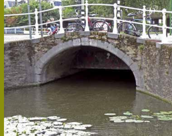
De Waterslootsepoortbrug. (MBK)
