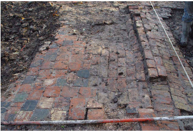
7-15 Vloer van plavuizen en bakstenen en binnenmuren van de oostvleugel.
