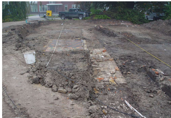
7-9 De fundering van de oostmuur van gebouw 1, kijkend richting de Bangert. Links van de muur ligt de plavuizen vloer van een kelder die in de 18 de eeuw aan het pand is toegevoegd.
