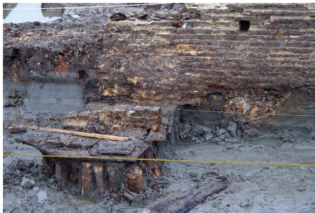
7-24 Detail van de fundering van het bakstenen bruggenhoofd. De poer in de omgrachting is gebouwd op slieten. In de muur van het bruggenhoofd is een van de gaten zichtbaar waarin de balken waren geplaatst waarop het houten brugdek rustte.
