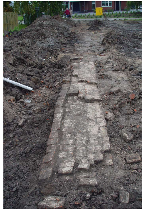
7-8 De fundering van de westmuur van gebouw 1 was nog in de bodem aanwezig, kijkend richting de Bangert.
