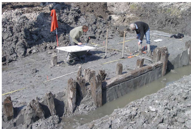
7-25 Palen van het noordelijke bruggenhoofd van een houten brug, geheel aan de zuidkant van het kloosterterrein. De sporen worden ingemeten en getekend door Guus van den Berg en Cees Aay.
