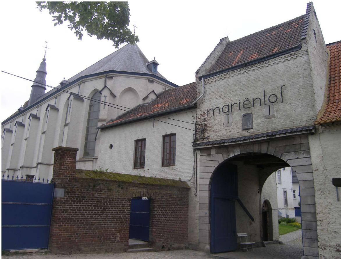
5-3 Poortgebouw en kapel van kruisbroedersklooster Mariënlof in Kolen, 2013. Onder het prioraat van Franciscus Vaes werd in 1535 de nieuwe kloosterkapel ingewijd.
