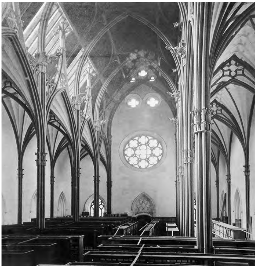
Het interieur van de Ridderzaal na de verbouwing door W.N. Rose. Dankzij de nieuwe gietijzeren dakconstructie kreeg de zaal, die onder meer zou dienen als bibliotheek, enigszins het aanzicht van een neogotisch kerkje. Foto van een onbekende fotograaf, ca. 1880 (collectie Rijksdienst Cultureel Erfgoed)
