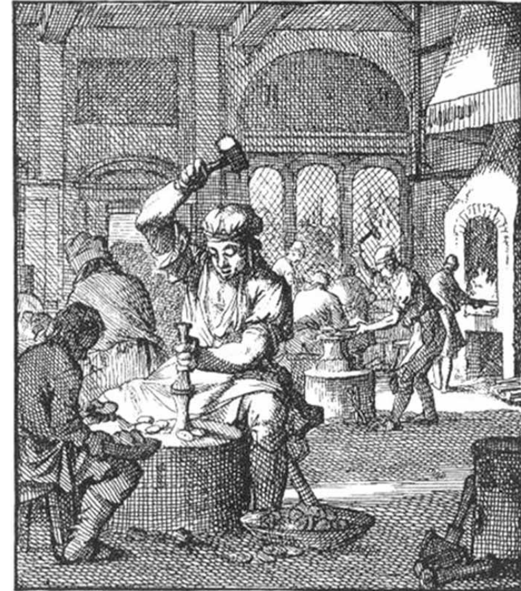
Afb. 1. De Munter, zoals afgebeeld door Jan Luycken in Het Menselyk bedryf (1694). Op de voorgrond een verbeelding van hoe munten met de hamer worden geslagen, op de achtergrond hoogstwaarschijnlijk het vlakken van een stuk metaal met een zogenaamde vlekhamer. Rechts is een oven te zien waaruit met een tang een kroesje met vloeibaar muntmetaal wordt gehaald.
