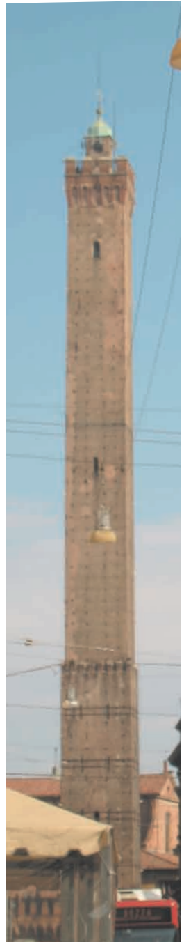
Torre degli Asinelli
