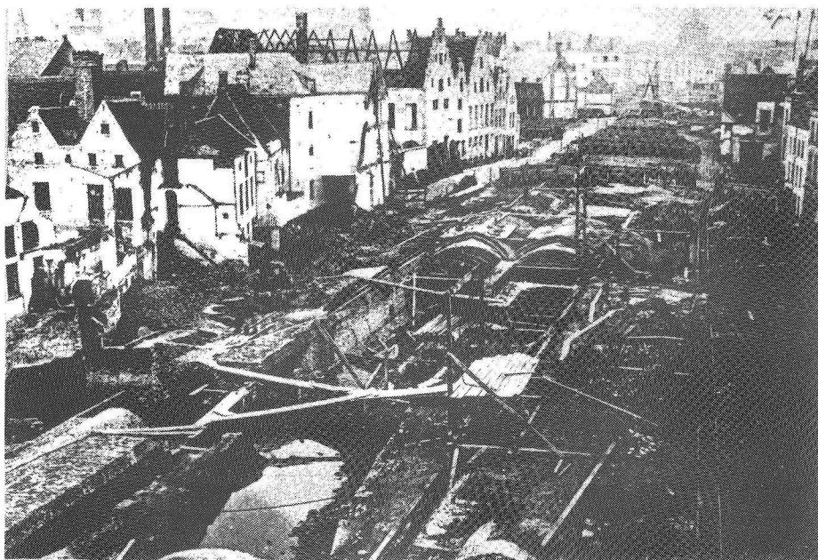
Figuur 4: de overwelfingswerken in 1870. Uit: G. Abeels, La Senne (Brussel 1983) p. 107.
