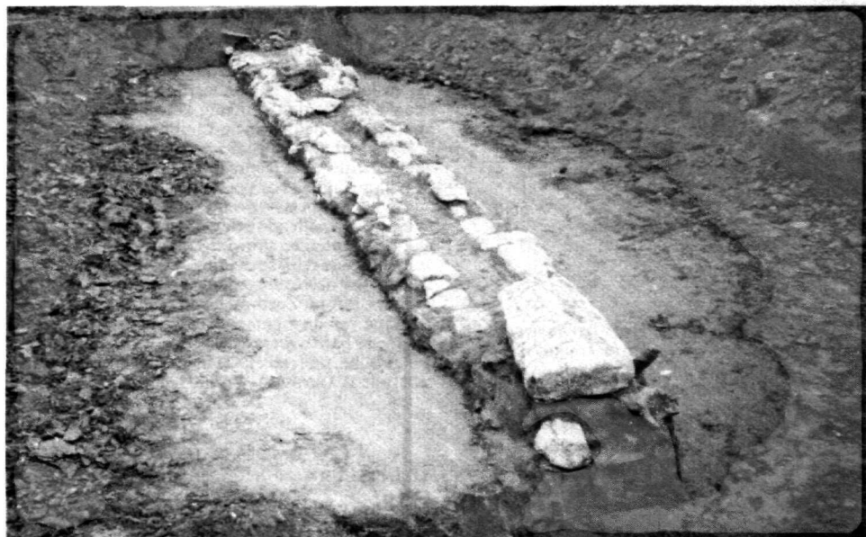
Afb. 9: De waterleiding naar de villa. Deze werd waarschijnlijk gevoed door de Hoensbeek waarvan de bron op 800 m vanaf het villaterrein ligt (zie afb. 1).
