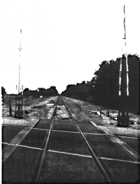
Foto 8.6: Op andere plaatsen, zoals bij de toegangsweg bij Veghel-noord, zijn de rails (nog) niet weggehaald.
